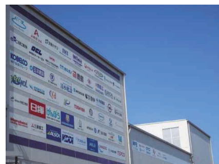
図 2.1.3-5 入退域管理棟壁面の協力企業看板
