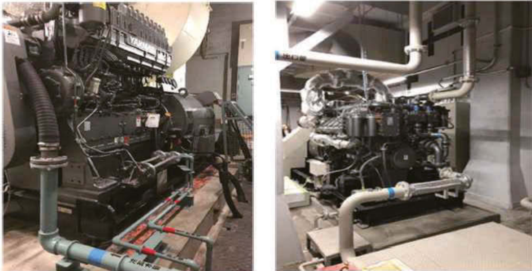
図3.3-1 非常用発電機の設置例
