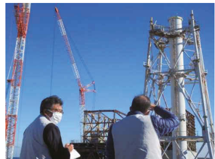
図 2.1.3-3 1号機前視察状況
