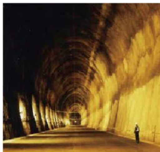
原油を貯めるための地下空洞 〈串木野国家石油備蓄基地(鹿児島県)〉 ※写真提供/独立行政法人石油天然ガス・金属鉱物資源機構(JOGMEC)
