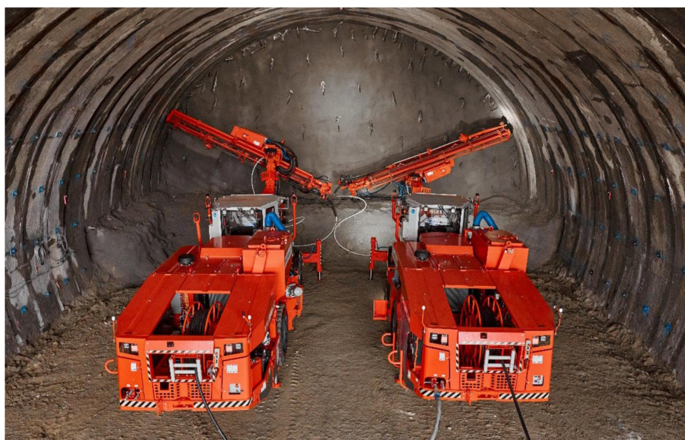
図 5-5 ロックボルト自動打設機の現場導入 53
