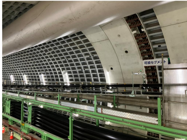
図 6-6 地中拡幅部（スチールセグメント）
