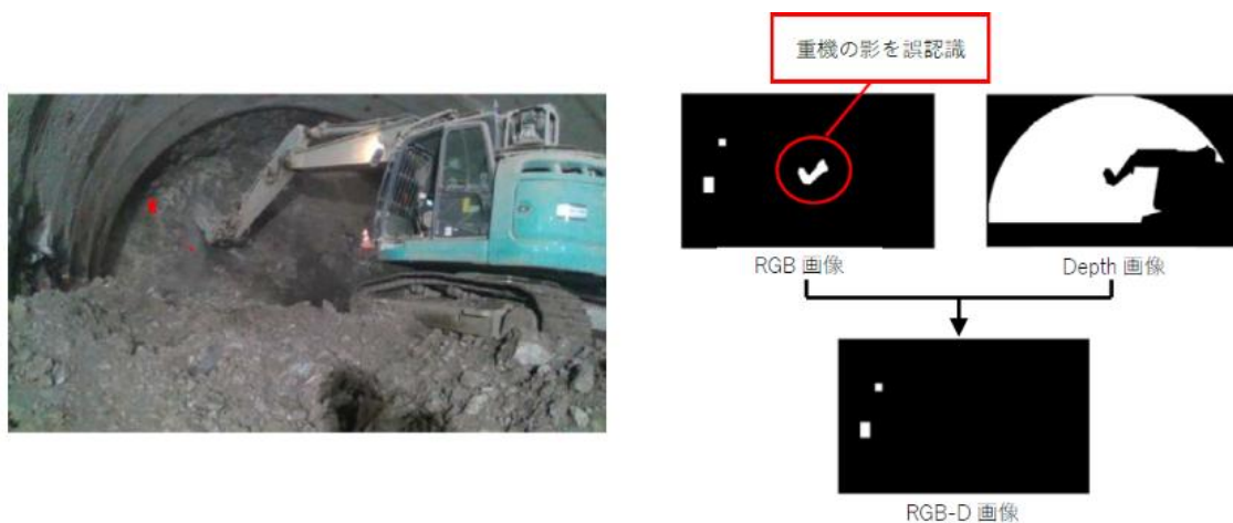
図 5-13 RGB-D 画像を用いた肌落ち検知状況 (左) と画像生成イメージ (右) 62
