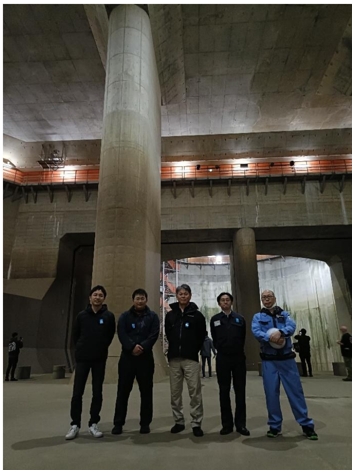
図 6-20 視察状況（於：調圧水槽）
