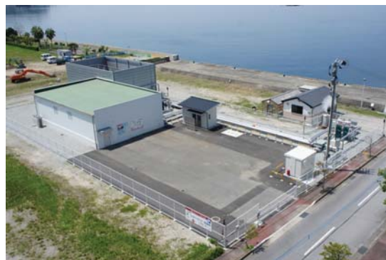
小規模地熱発電所
