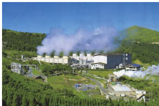
大規模地熱発電所
