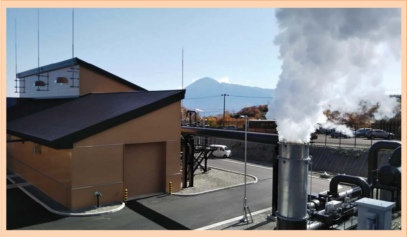
発電所と岩手山 2018年10月 試運転中
