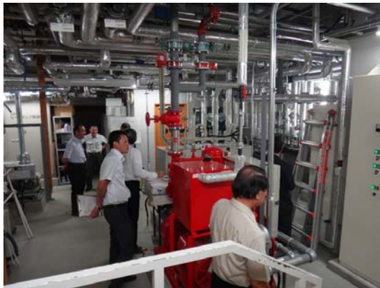
病院内 暖房設備
