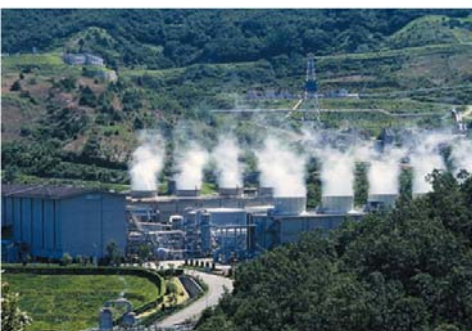
地熱エネルギーの利用
