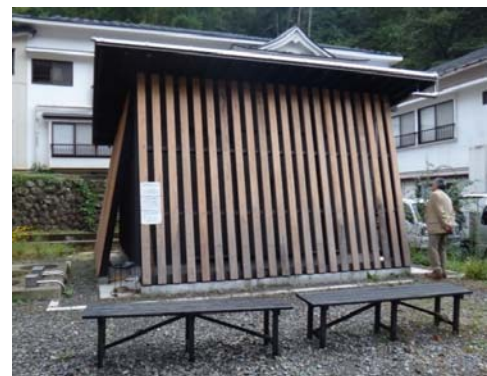
温泉供給設備
