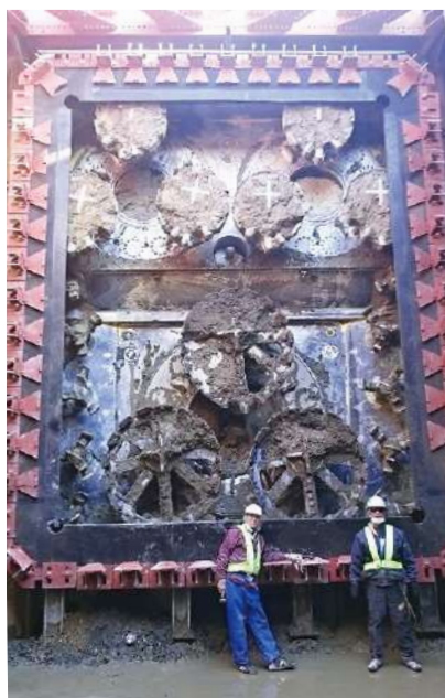
国道6号（茨城県内）横断車歩道掘進機 到達
