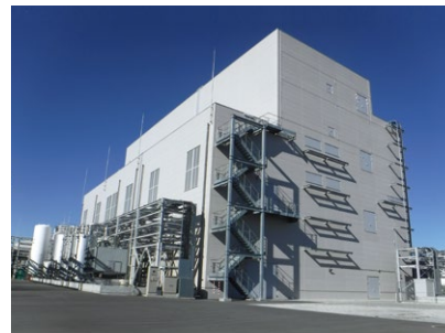
第一三共ケミカルファーマ株式会社様 高薬理活性医薬品製造設備 最新の封じ込め技術で原薬生産工場の 拡張を実現
