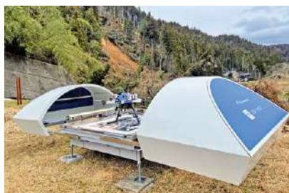
能登半島災害対応_土砂ダムの監視
