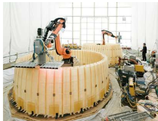
3Dプリンターによる施工
