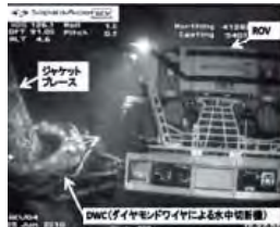
図2 ROVによるDWCのジャケット部材への海中での取付状況
