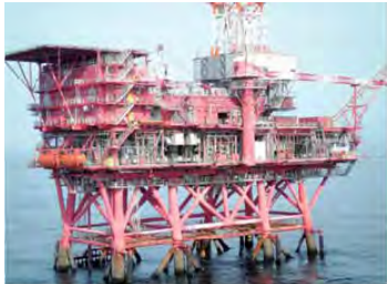
図1 磐城沖プラットフォーム(撤去前状況) Fig. 1 Offshore Iwaki Platform (before decommissioning)
