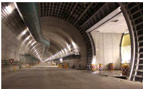
Uターン路完成時
