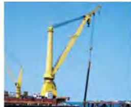
図3 杭撤去作業状況
