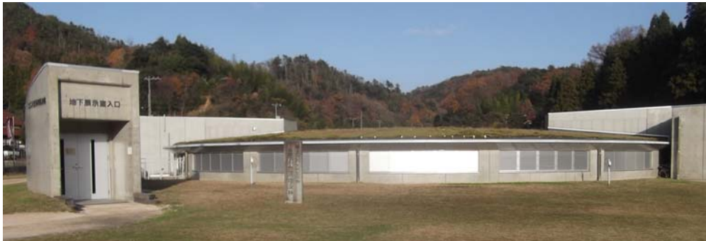
縄文の森保存発掘展示棟外観
