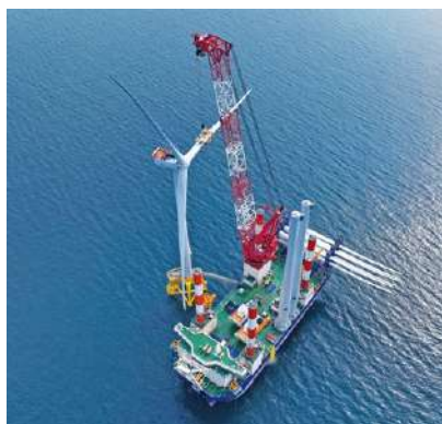
洋上風力建設
