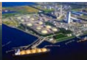
LNG輸送船と受入基地・ 東京電力(株) 富津火力発電所
