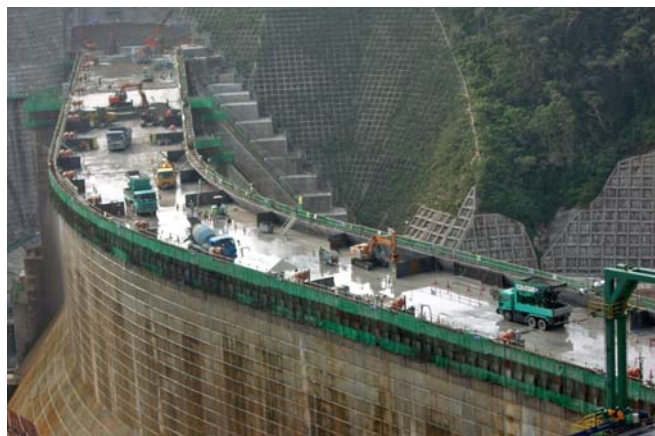
大保ダム建設状況
