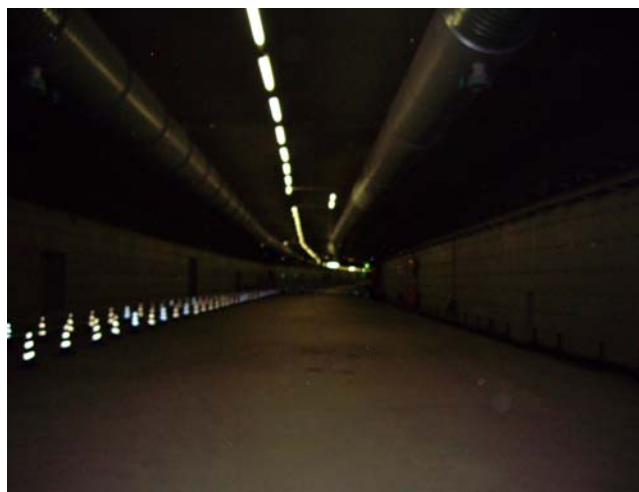
海底トンネル内部
