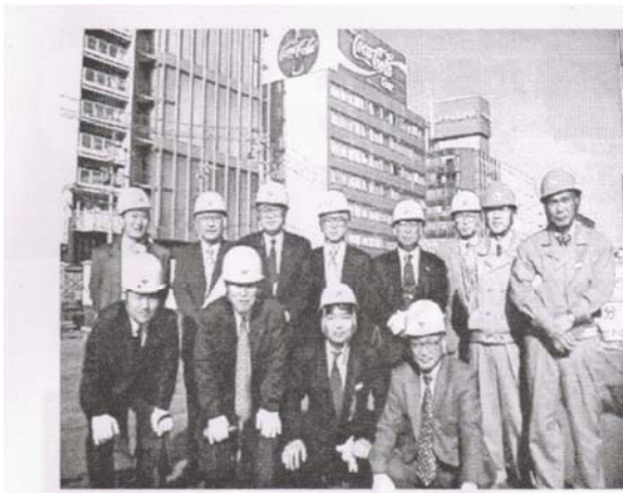
栄公園地区新築工事現場にて
