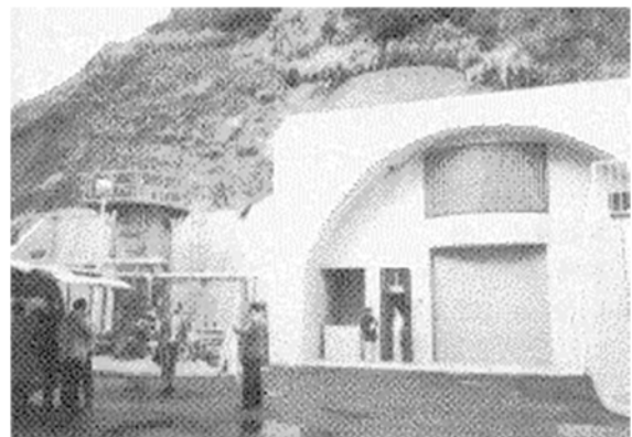
水処理施設入り口付近
