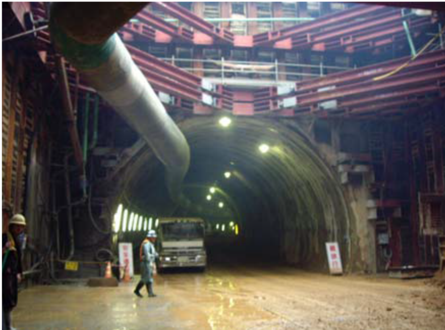
八木山トンネル坑口
