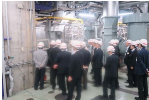
札幌駅南口エネルギーセンター見学の様子
