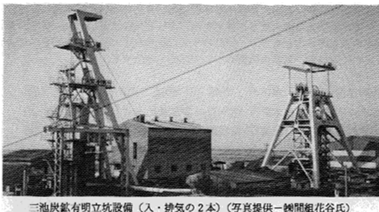
三池炭鉱有明立坑設備（入・排気の 2 本）（写真提供—瞬間組花谷氏）
