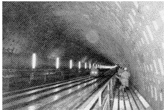
シールドトンネル(木更津人工島)
