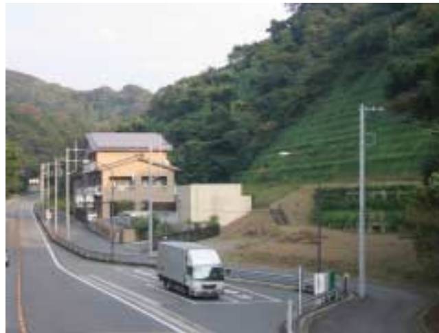
全景（のり面の中に 2 本のトンネルがある）
