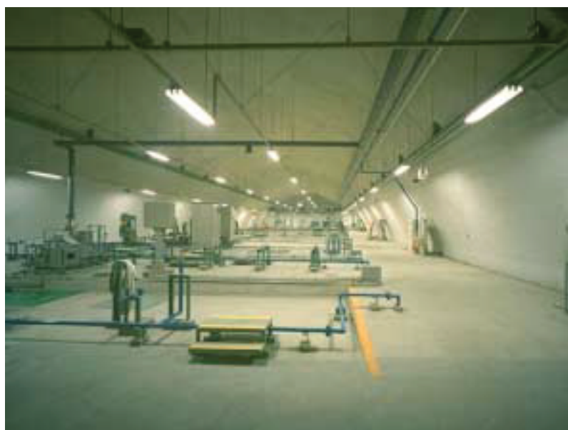
浄化センター内部
