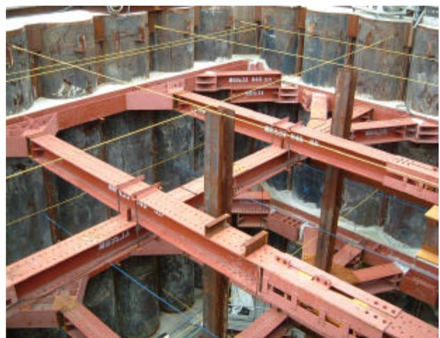
土留支保工（鋼製 H 型鋼、5 段切梁）
