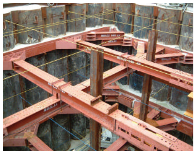
土留支保工（鋼製 H 型鋼、5 段切梁）
