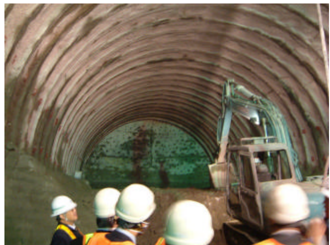
アプローチトンネル先端部
