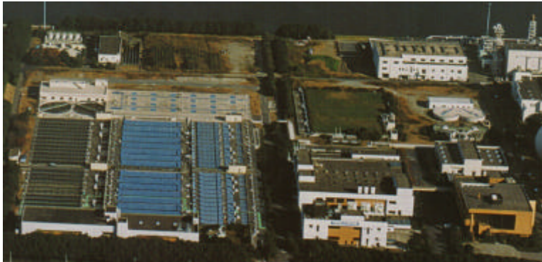
下水処理場全景
