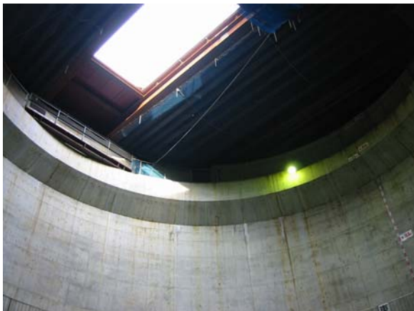
写真1 若江立坑（直径：22m、深さ25m）
