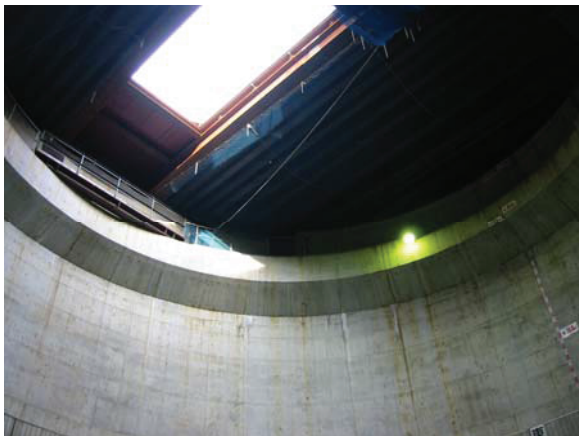
写真1 若江立坑（直径：22m、深さ25m）
