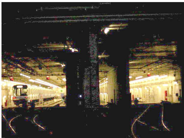
写真1 大幸車庫入線部付近
