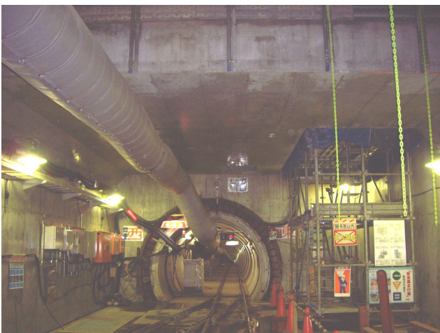
富津側 坑口風景坑内状況
