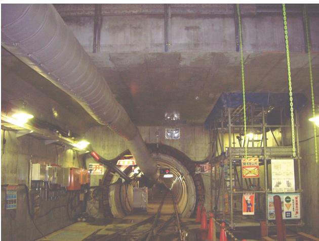
富津側 坑口風景坑内状況
