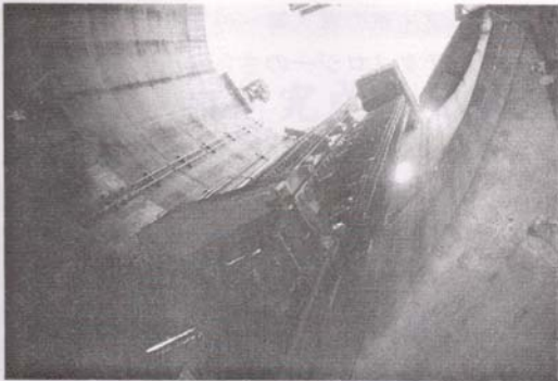
首都圏外郭放水路立坑見上げ写真
