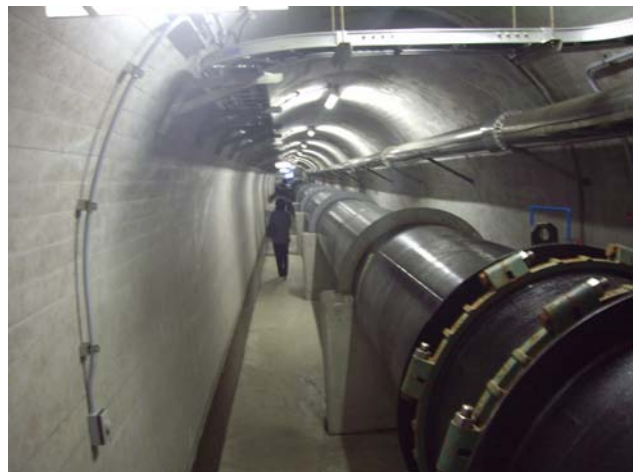
配水所内状況
