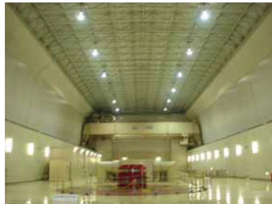
写真 1 発電所空洞内部状況
