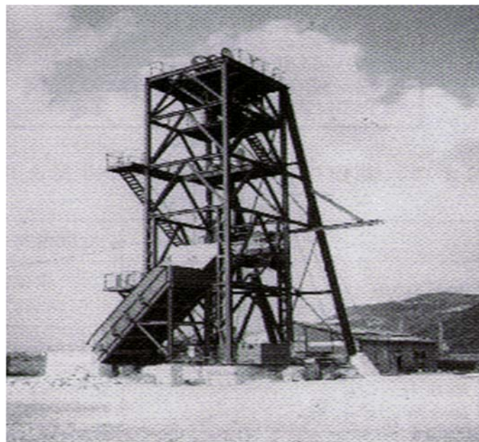
実証プラント立坑櫓
