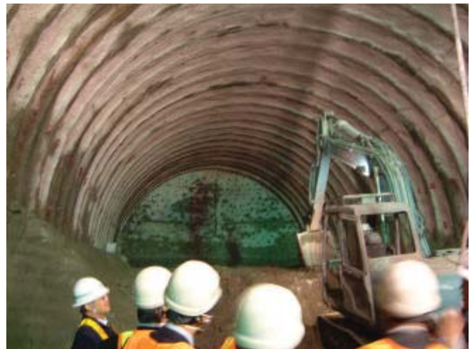
アプローチトンネル先端部
