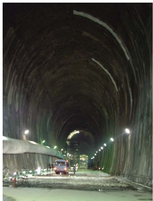
施工中の貯槽
