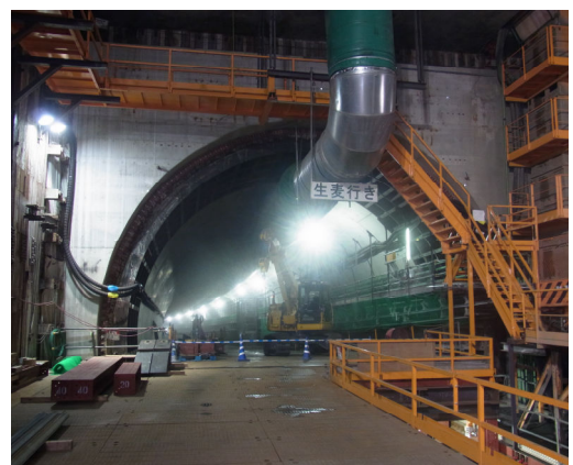
写真-1 トンネル施工状況
