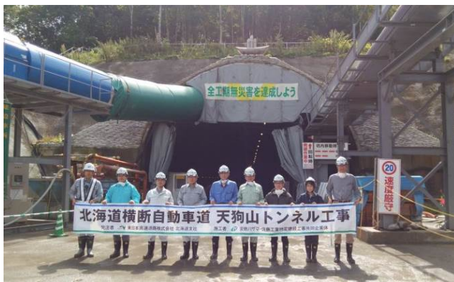
天狗山トンネル坑口にて (右上側がベルトコンベア)
