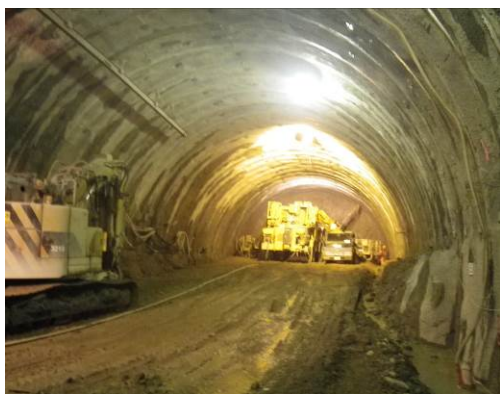
トンネル掘削状況
