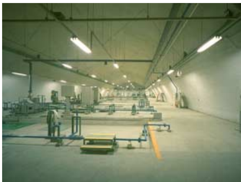
浄化センター内部
