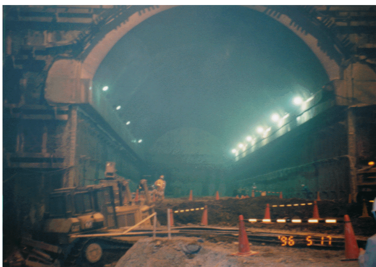
建設中の葉山浄化センター
