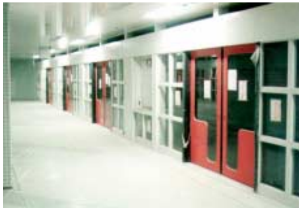
施工中の御池地下街('96.11)
