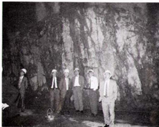
地下空洞内にて
