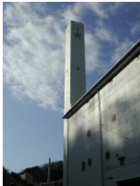
写真 3.4.2-1 桜井清掃工場
