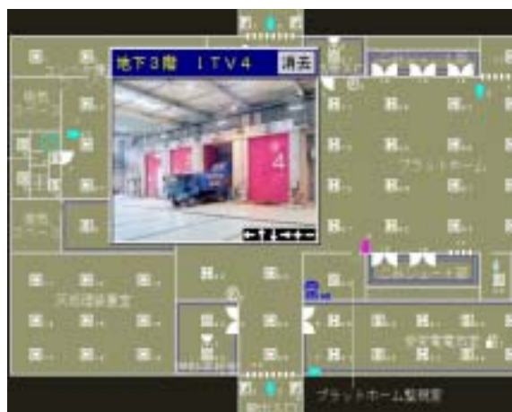
図 3.2.5-30 プラットホームの様子
