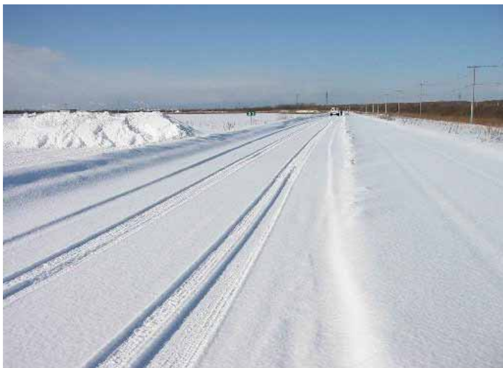
写真 3.3.3-3 試験道路の状況
