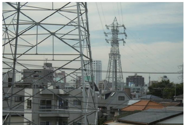
写真 2. 2. 2-17 住宅密集地上空の送電線
