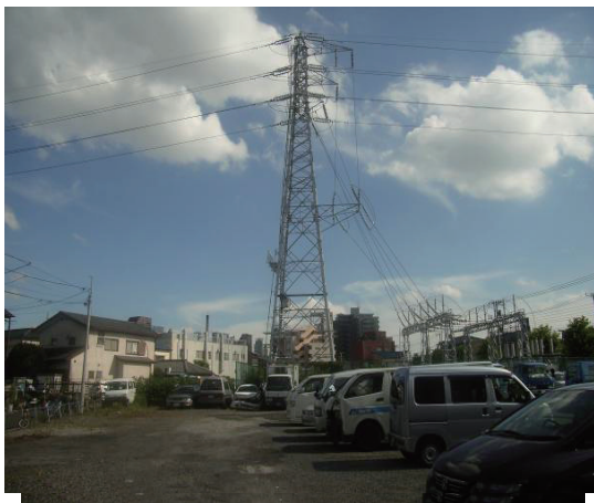
写真 3.4.5-1 現地踏査で確認された 地中へ分岐する送電線
