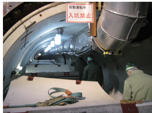
トンネル坑内
