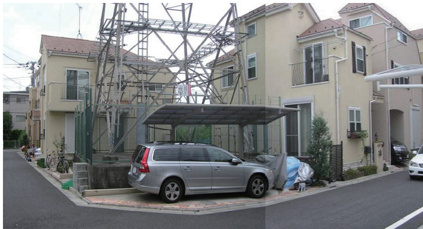
写真 2.2.2-7 小規模開発の1区画を占有する鉄塔
