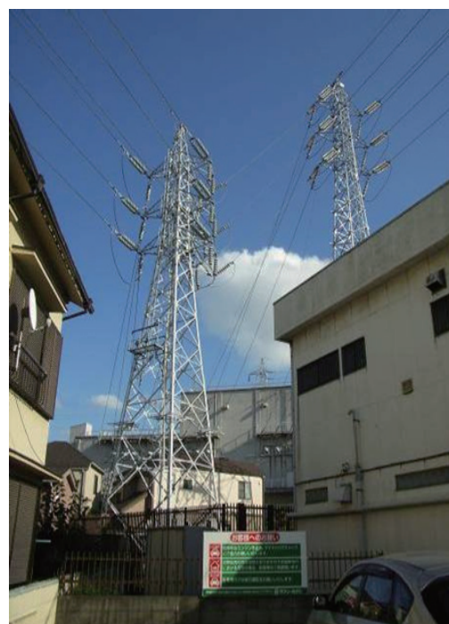
写真 2.2.2-11 住宅街に建つ鉄塔
