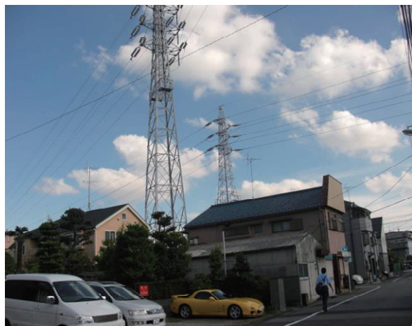
写真 2. 2. 2-15 住宅街に建つ鉄塔（2 系統）
