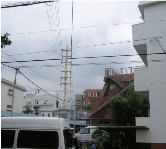
写真 2.2.2-1 住宅街の中の美化鉄塔
