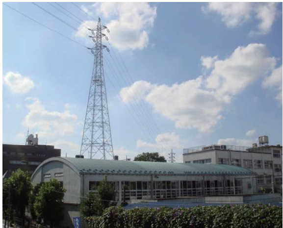
写真 2. 2. 2-14 学校横に建つ鉄塔
