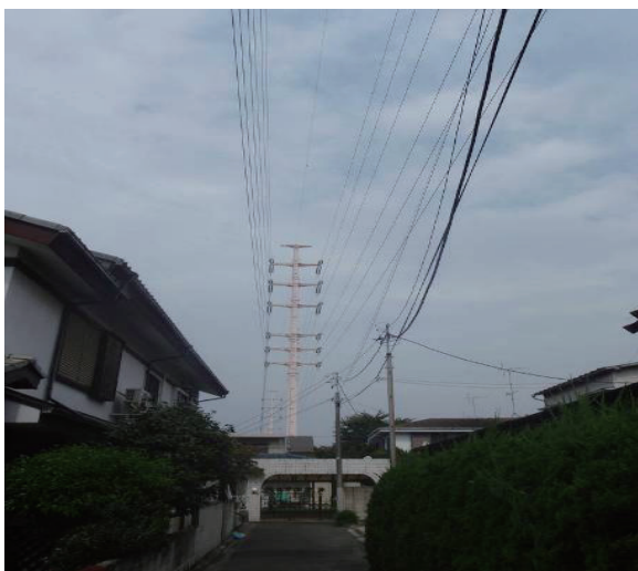
写真 2.2.2-8 住宅街に建つ美化鉄塔
