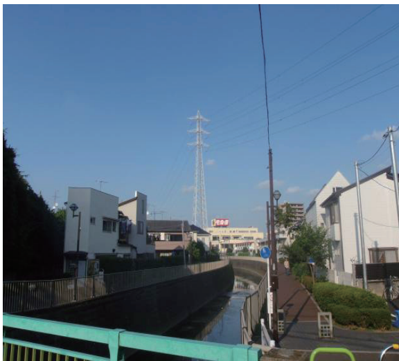
写真 2.2.2-3 河川右岸に建つ鉄塔
