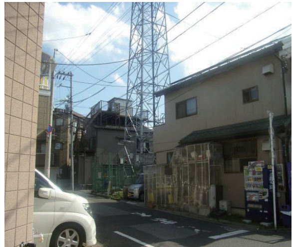
写真 2. 2. 2-13 住宅街に建つ鉄塔
