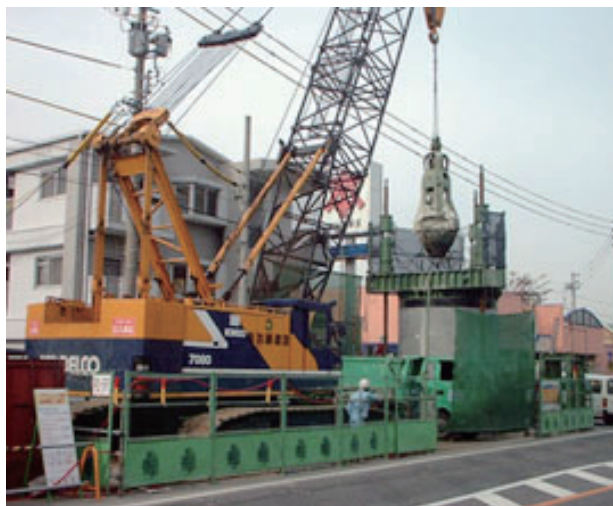
写真 3.4.5-3 プレキャスト部材を圧入 する方法の施工状況 出典：PC ウェル工法研究会 HP
