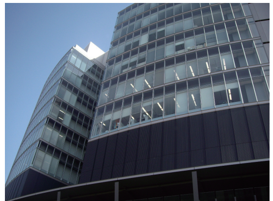
写真-2 新豊洲変電所上部のデータセンター
