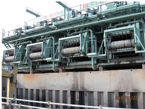
掘削土砂処理施設
