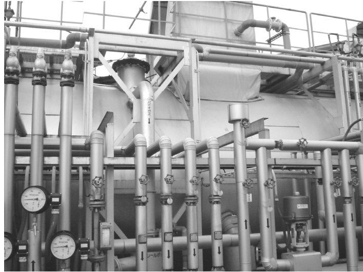
図.2-1-18 コンポガス発酵槽
