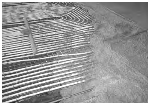
図.4-2-22 床暖房施工例（左：融雪用、右：床暖房（右ヘッダー部））
