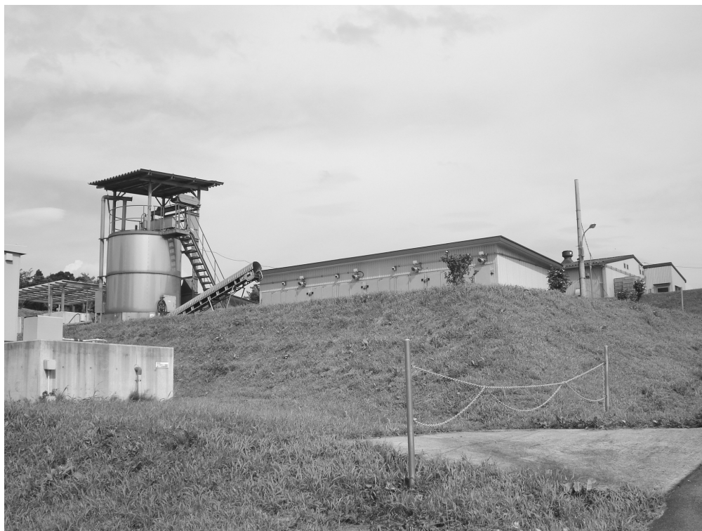
図.3-2-1 奈良県畜産技術センター家畜ふん尿処理施設全景 （左：高速たい肥化装置、右：ガレージ式発酵槽（4室））
