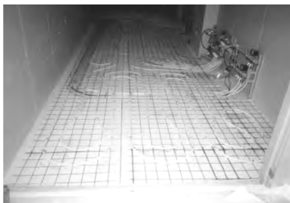
図.4-2-22 床暖房施工例（左：融雪用、右：床暖房（右ヘッダー部））
