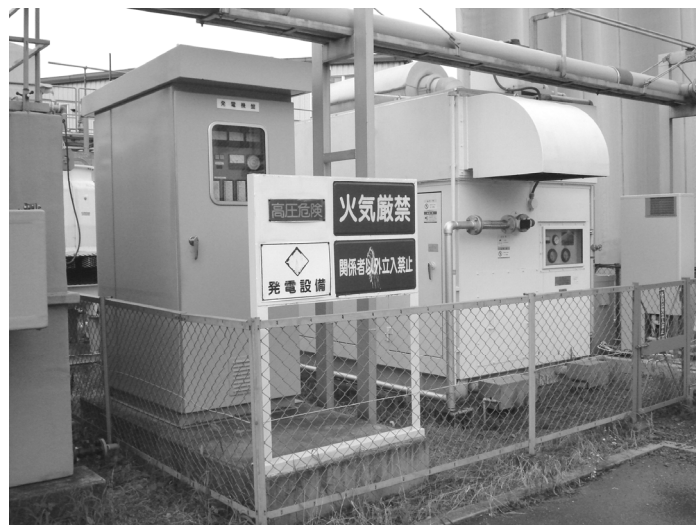
図.2-1-20 ガス発電機
