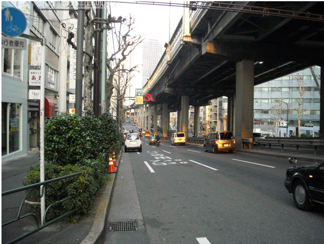
図 3.4.3-2 六本木通りの状況（六本木より溜池方面 北側）
