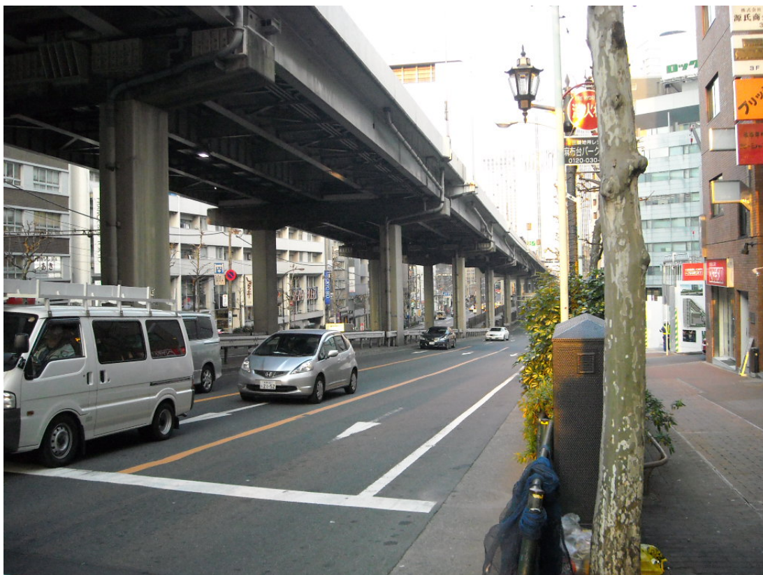
図 3.4.3-3 六本木通りの状況（六本木より溜池方面 南側）
