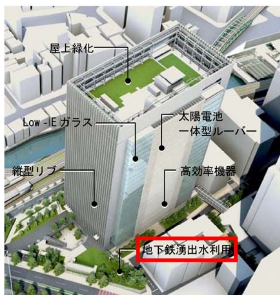
図 2.1.5-4 地下鉄湧出水利用位置
