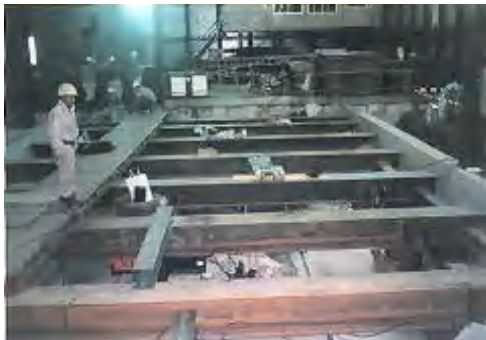
写真 5.2.2-6 防振装置による防振覆工
