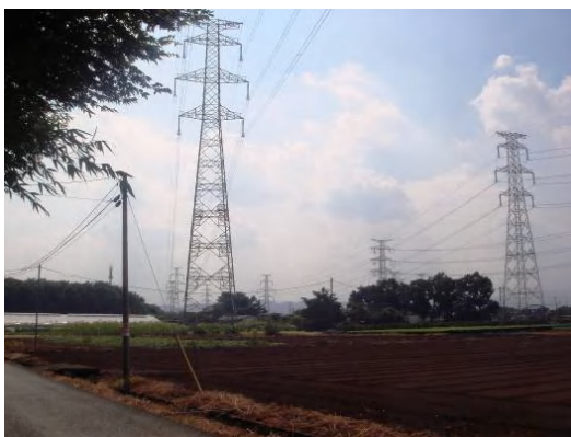
図 2.2-9 新所沢～中東京変電所間 架空送電線
