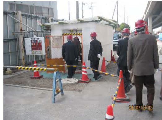
新磯子町第 1 立坑入り口付近
