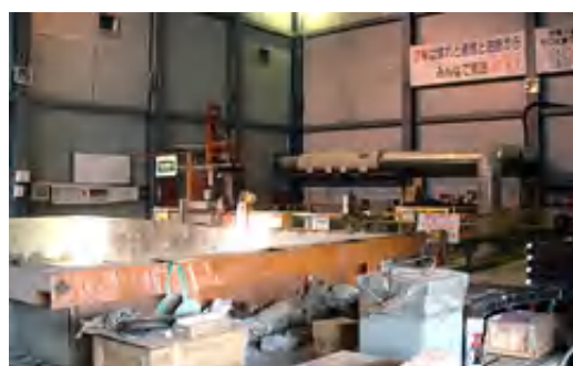
写真 5.2.2-2 防音ハウス内部
