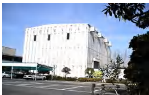
写真 5.2.2-1 防音ハウス例 1
