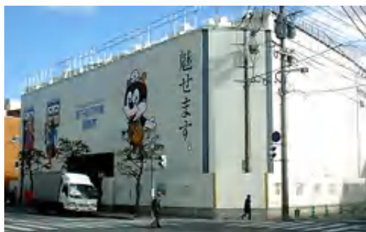
写真 5.2.2-3 防音ハウス例 2
