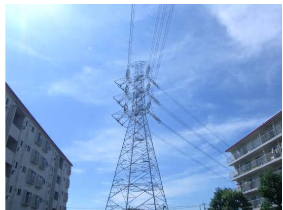
図 2.2-14 集合住宅内架空送電線
