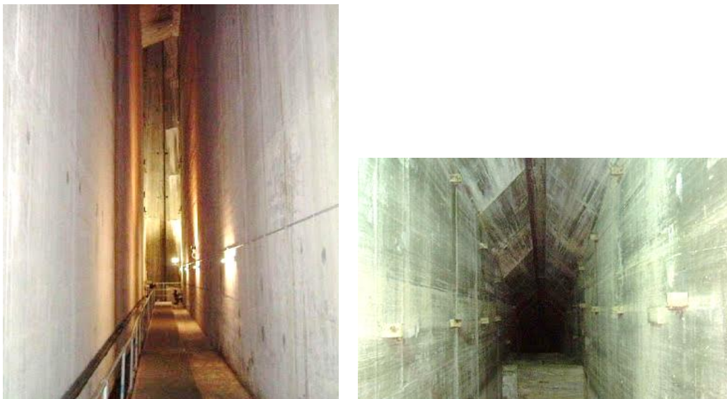
図 3.3-5 堤体内の幅 2m のスリットと貯水池側のウェッジプラグ http://mightyclutha.blogspot.jp/2009/03/clyde-dam-slip-joint-problem.html
