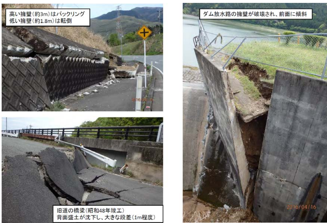
図 3.1-22 大切畑ダム施設と北側道路周辺の被害（清田ほか，2016）
