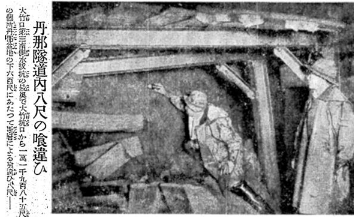
図 3.1-2 丹那トンネル水抜き坑切羽に出現した八尺の断層変位（東京日日新聞，1930）
