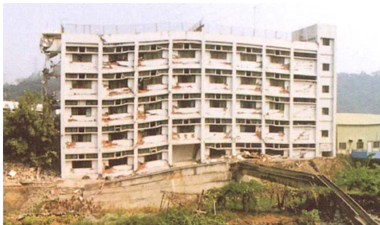
図 3.2-3 断層変位による RC 構造物の被害（柔基礎支持）（Faccioli et al., 2008）
