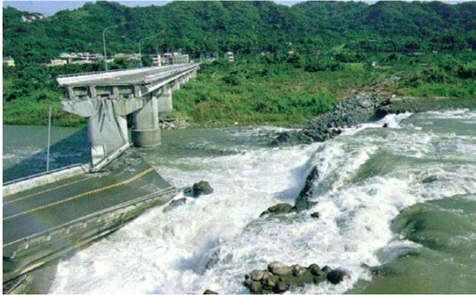
図 3.2-8 Bei-Feng 橋上流側に生じた断層変位（中村・大角，1999）
