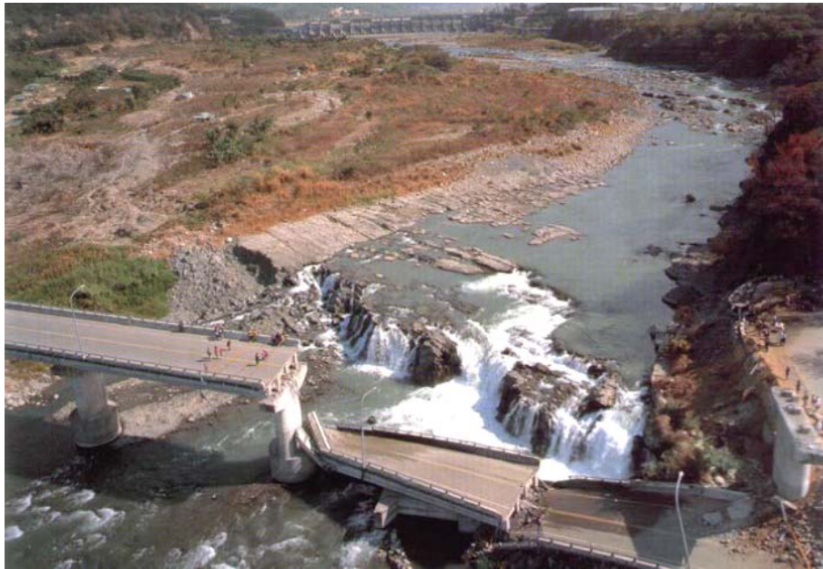
図 3.2-6 断層変位により崩壊した Bei-Feng 橋 (Faccioli et al., 2008)
