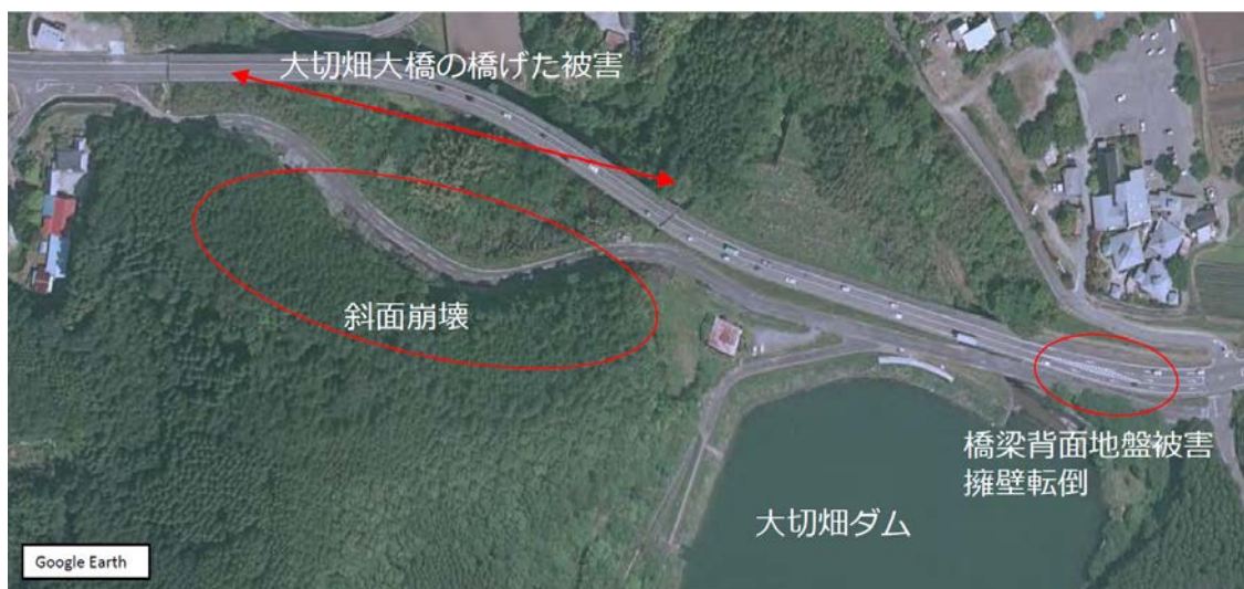
図 3.1-21 大切畑ダム北側道路の被害（清田ほか，2016）
