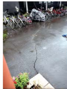
写真-4 図-8の地点②で確認したわずかな南西側落ちの上下変位を伴う開口亀裂。南東に向かって平成28年5月10日撮影。
