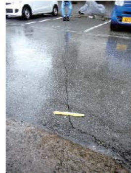
写真-3 図-8の地点①で確認した道路の開口亀裂。北西に向かって平成28年5月10日撮影。
