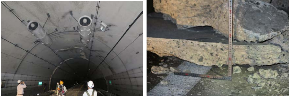
図 3.1-18 x 字型クラック（左）と落下した厚さ 10 cm 程度のコンクリート破片
