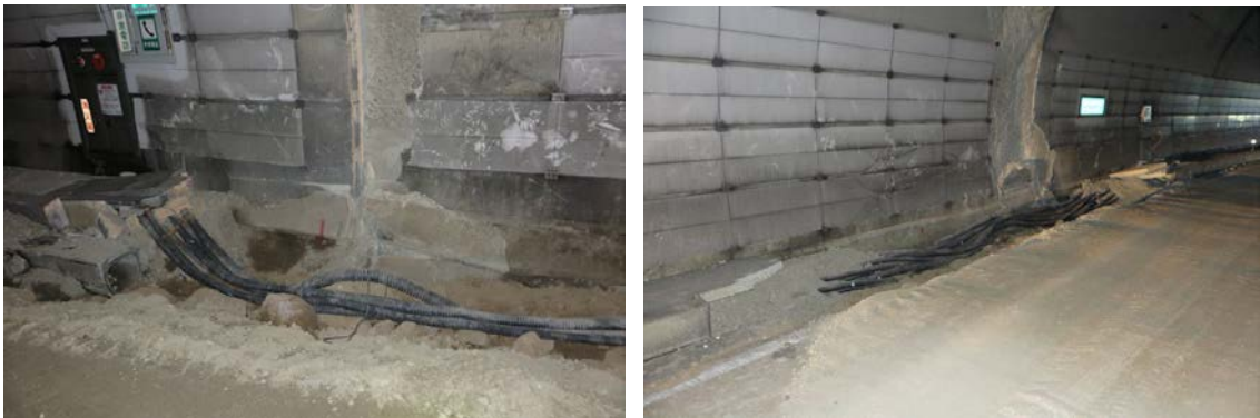
図 3.1-19 盤膨れ部の側壁部（インバートが破壊）
