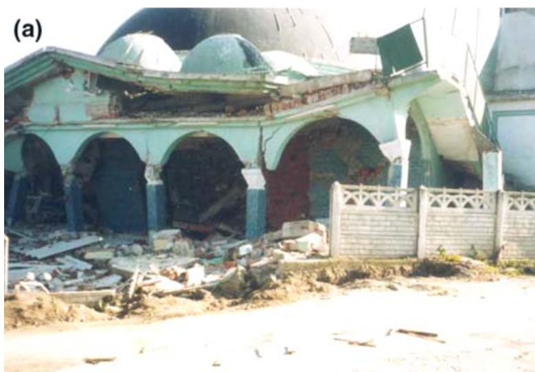
図 3.2-10 断層変位による RC 構造物の被害（柔基礎支持）（Faccioli et al., 2008）
