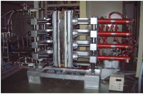
図 8.2.2-2 電解槽締付装置と 2 セル電解槽
